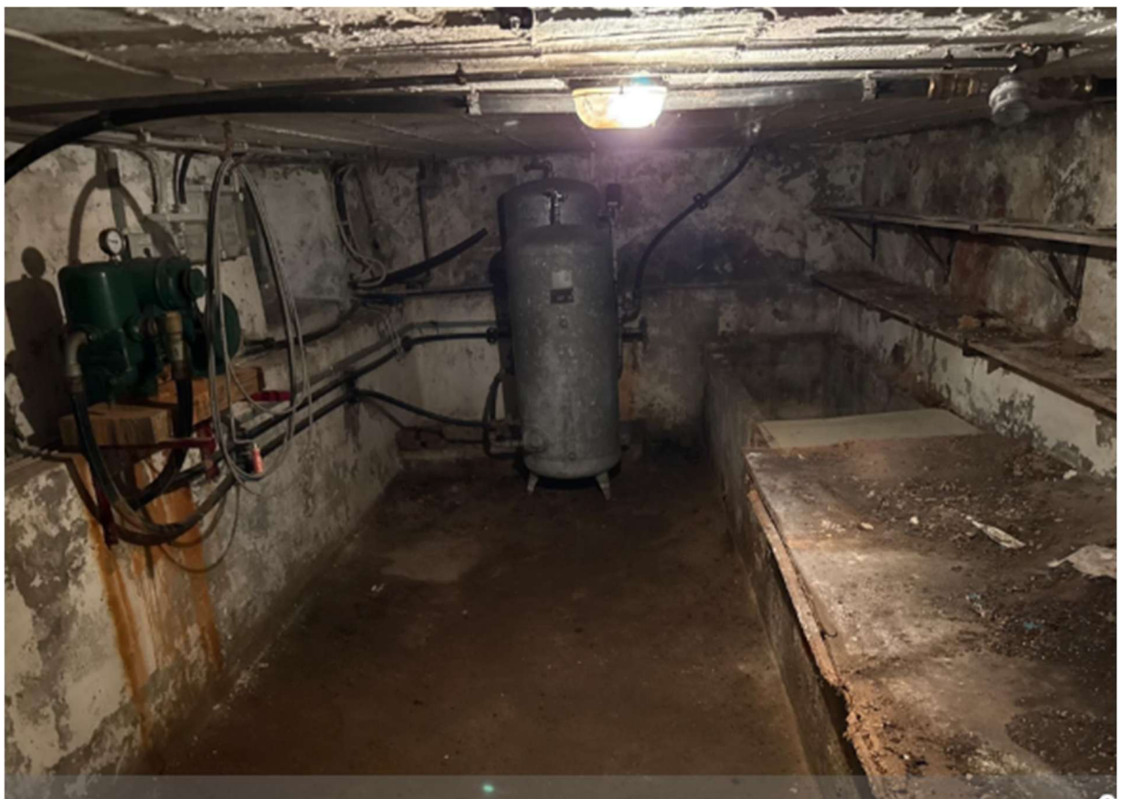
Wasserpumpe und Filteranlage Versorgungskeller
